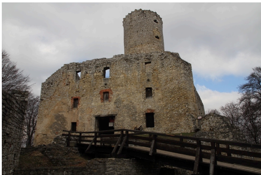
il.10 Elewacja południowa, widok ogólny.
