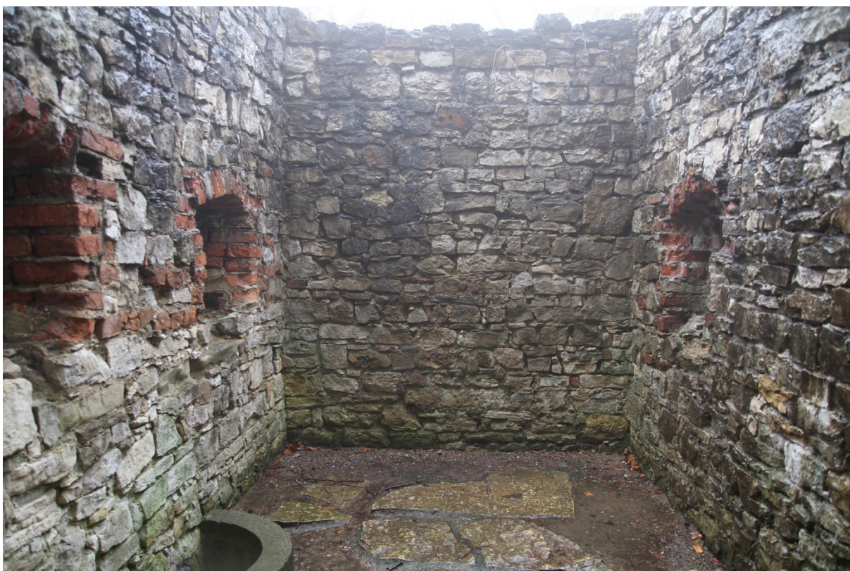
Fot.35. Zamek w Lipowcu, II piętro. Stan zachowania wątków kamiennych i ceglanych.
