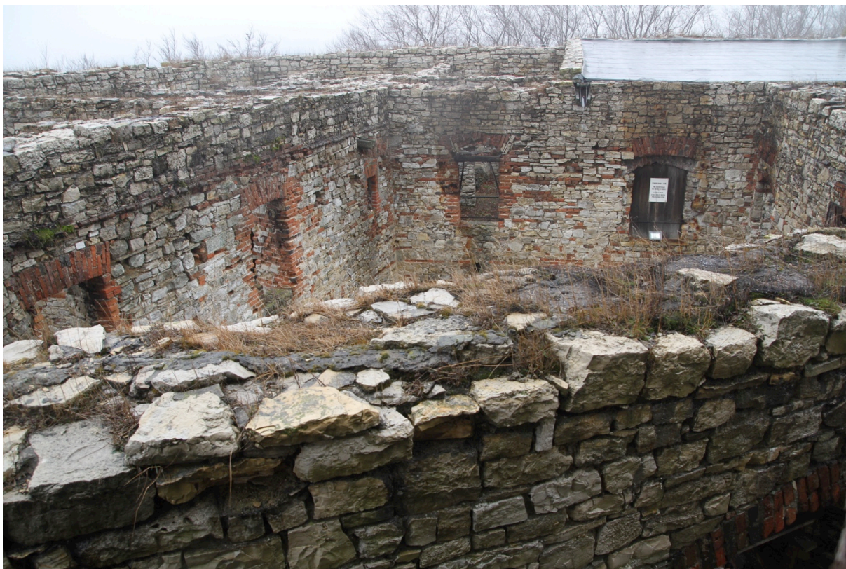
Fot.13. Zamek Lipowiec. Korony murów.
