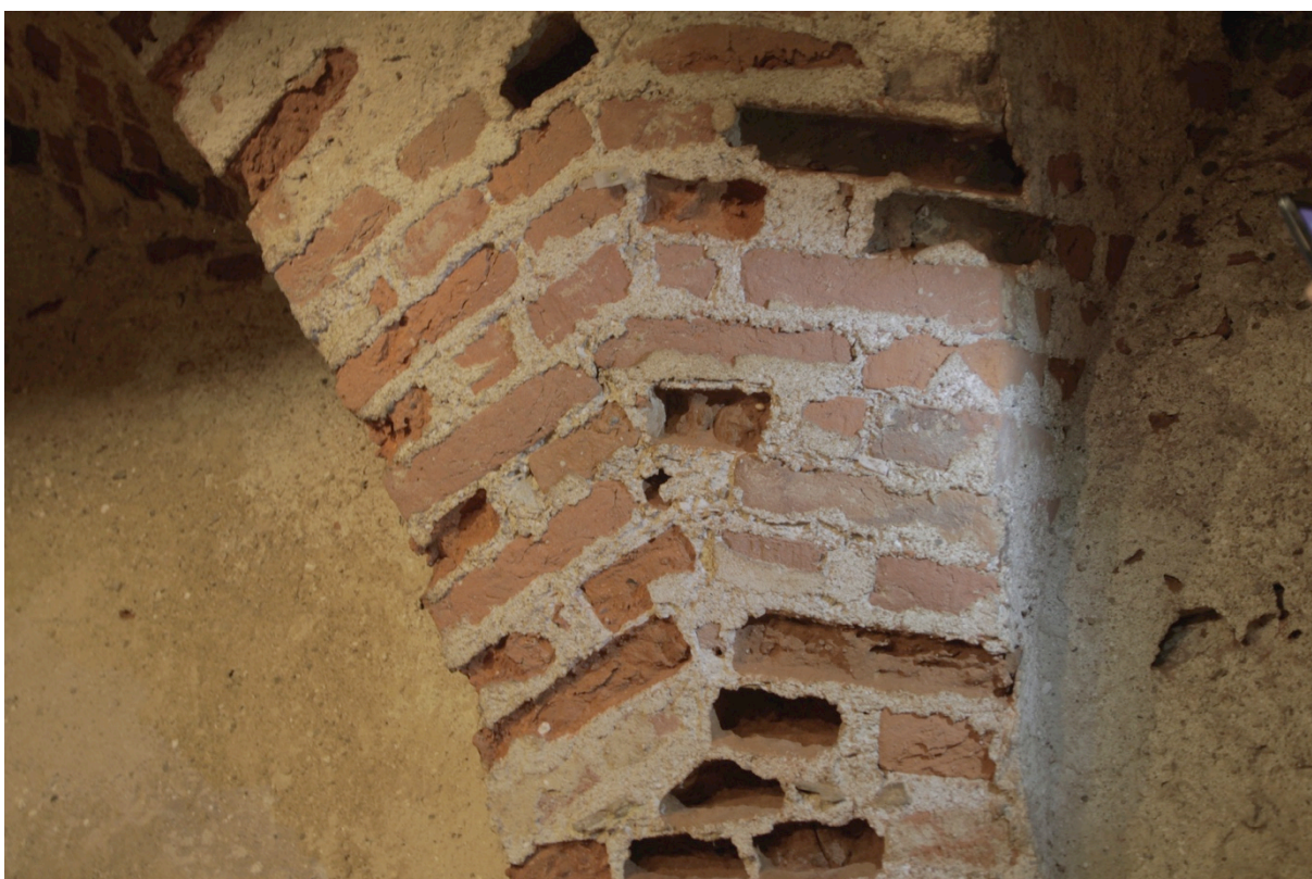
Fot.26. Zamek w Lipowcu, parter, refektarz. Ubytki wątku ceglanego.
