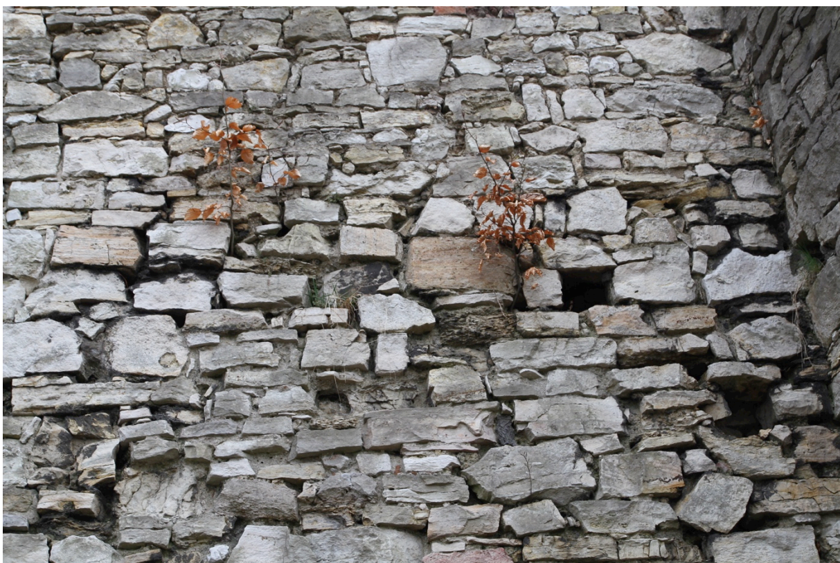
Fot.12. Zamek Lipowiec. Stan zachowania wątków kamiennych na murach obronnych z samosiejkami drzew.
