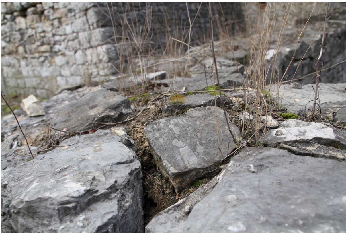
Fot.15. Zamek Lipowiec. Korony murów.
