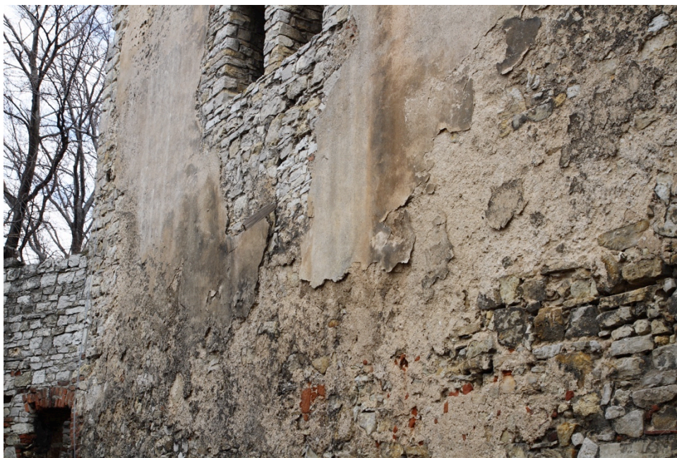
il.14 Elewacja zachodnia, stan zachowania wypraw tynkarskich.
