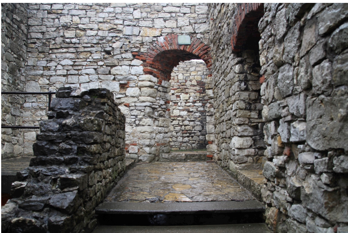
Fot.37. Zamek w Lipowcu, II piętro. Stan zachowania wątków kamiennych i ceglanych.
