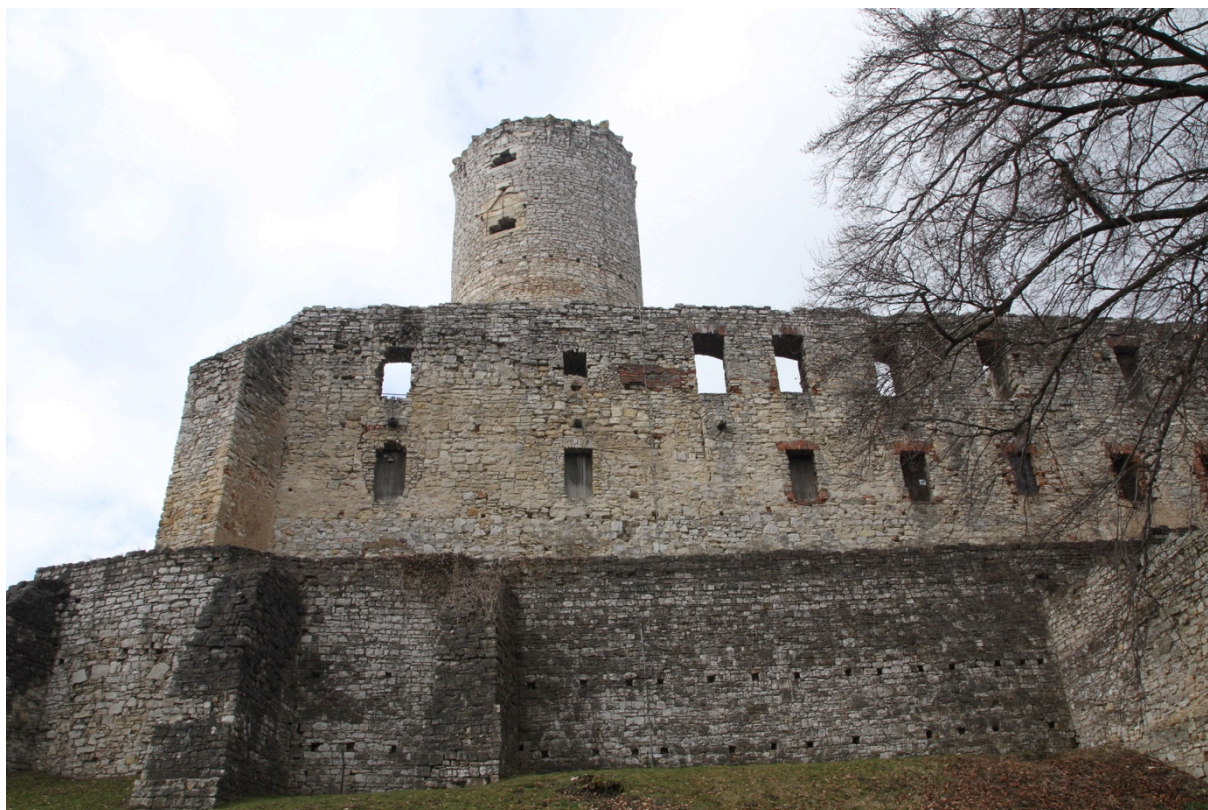
Fot 1. Zamek Lipowiec, Elewacja wschodnia zamku górnego.
