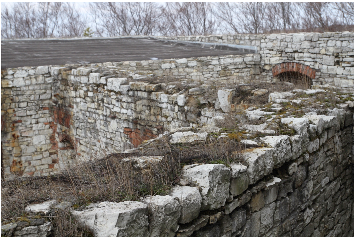
Fot.14. Zamek Lipowiec. Korony murów.
