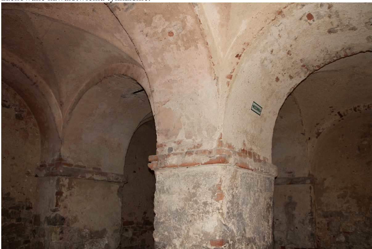
Fot. 31. Zamek w Lipowcu, parter, wozownia.
