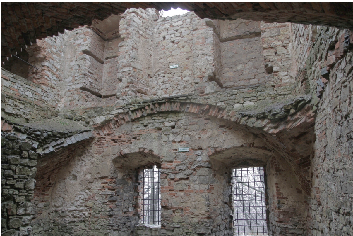
Fot.21. Zamek w Lipowcu, parter, skarbiec.
