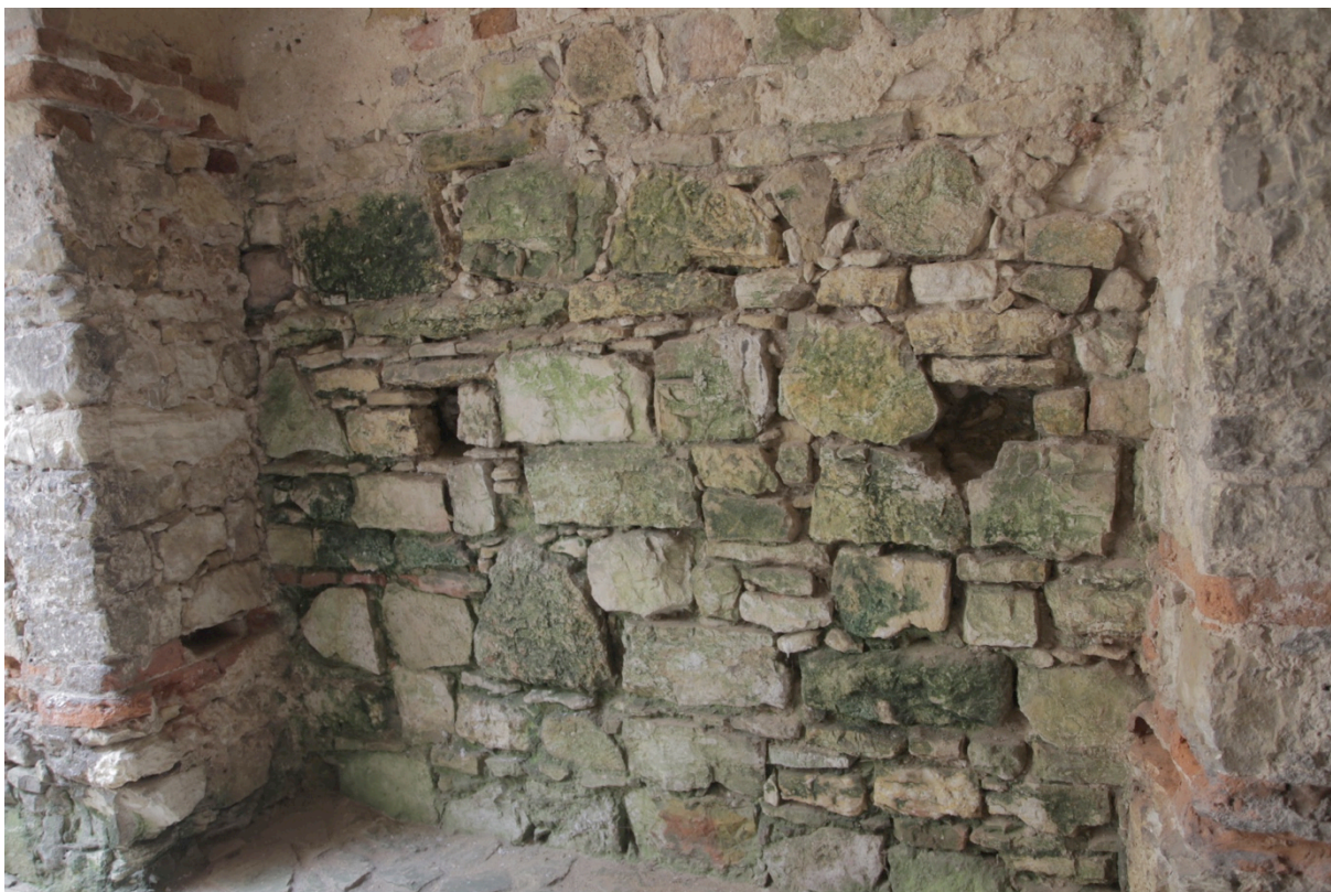
Fot.23. Zamek w Lipowcu, parter, wozownia. Wątek kamienny pokryty glonami i porostami na ścianie wozowni.
