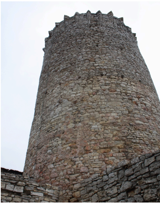
il.18. Wieża, widok ogólny.
